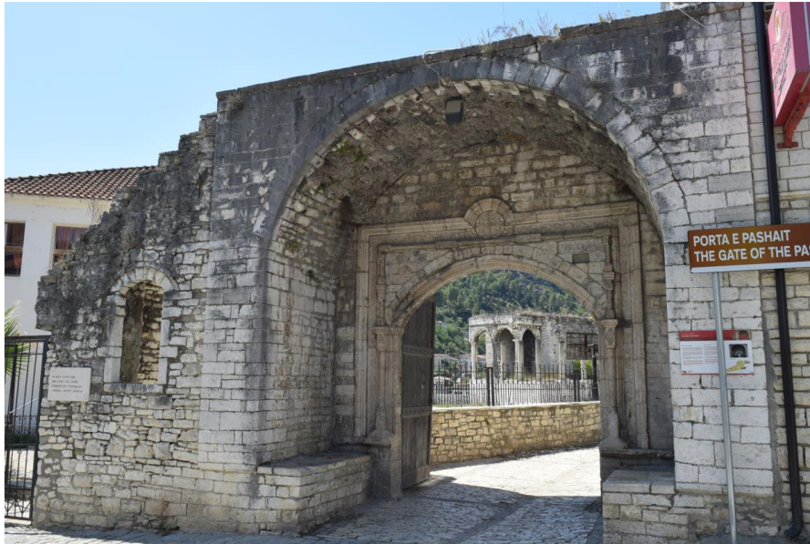
Gjendja ekzistuese e Portës së Pashait
