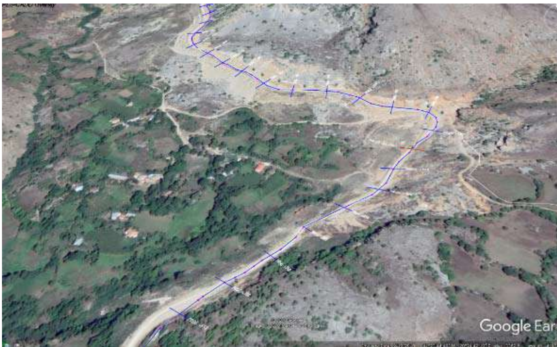
Figurë 25:Km 24, objekti me prane aksit te rruges 140m
