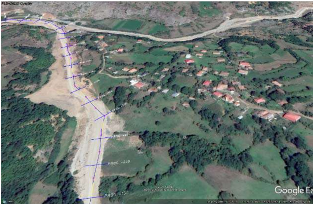
Figurë 23:Fshati Borove Km 17+00-18+00 ,objekti me prane aksit te rruges 70m
