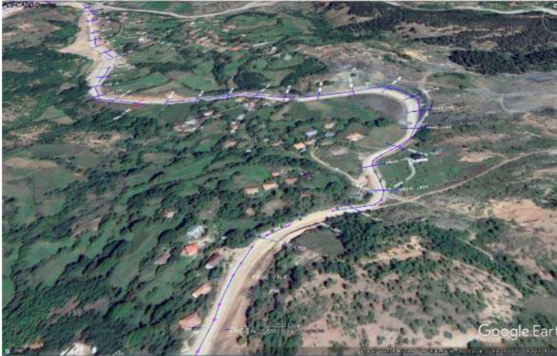
Figurë 22:fshati Borove, Km 16+00-16+950 ,objekti me prane aksit te rruges 10 m
