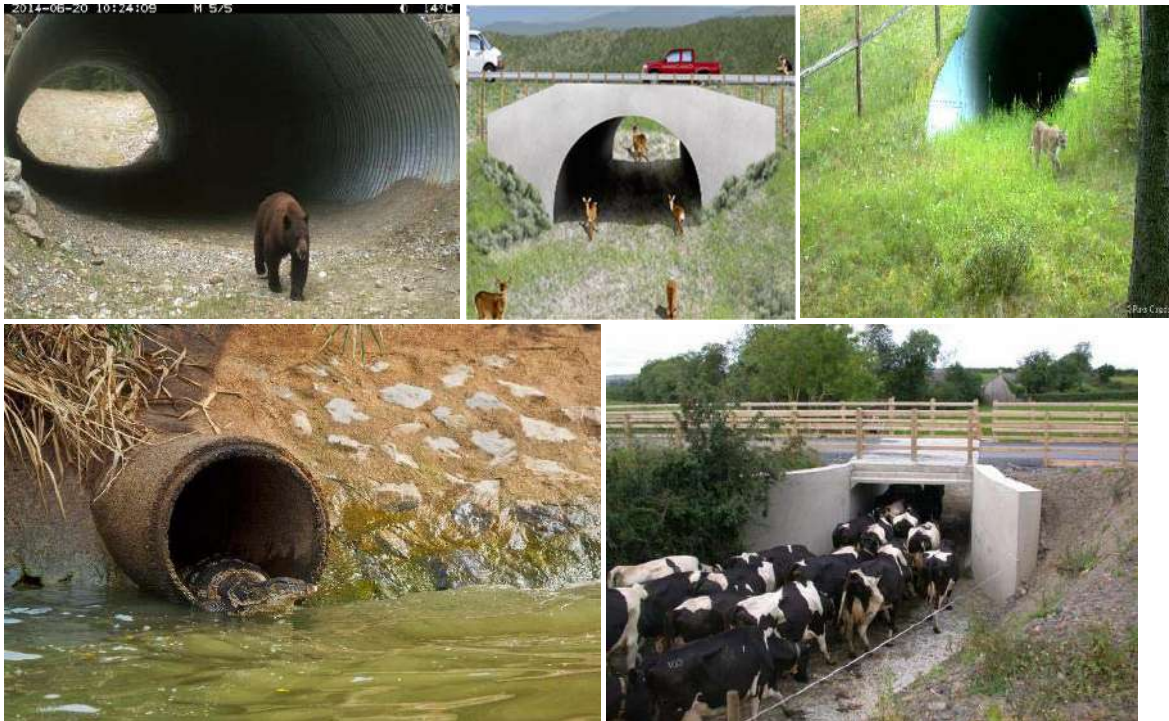
Figurë 68:tombinot dhe box culvert si kalime per kafshet
